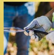
**ПОДГОТОВКА** Перед сваркой кабель разделяется на длину 1,5–2 м. Это значит, что с него с помощью специального инструмента, стриппера, снимается верхняя оболочка и слой металлической гофры. Под оболочками обнажаются модули — сгруппированные в отдельных оболочках пучки оптических волокон. Количество волокон в каждом модуле зависит от емкости кабеля. Их может быть 4, 8 или даже 28.
