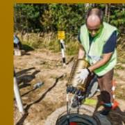
**СБОРКА** После сварки на место стыка надвигается термоусадочная гильза, которую мастер заранее надел на одно из волокон. Термоусадка происходит внутри печки, которая является частью сварочного аппарата. Гильза, укрывающая стык, будет установлена на специальный элемент внутри муфты. После окончательной сварки всех составляющих кабель волокон и установки гильз на ложементы крышка муфты плотно закрывается и опускается в колодец.
